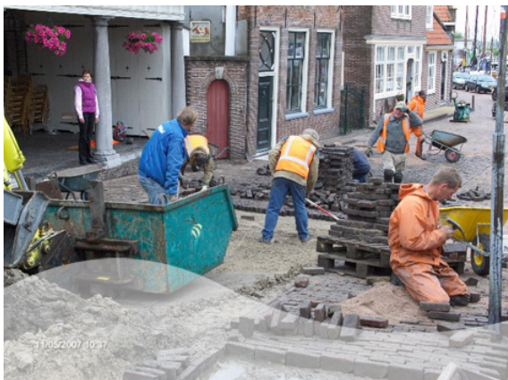
Aanleg van elementerverharding havenstraat Monnickendam
