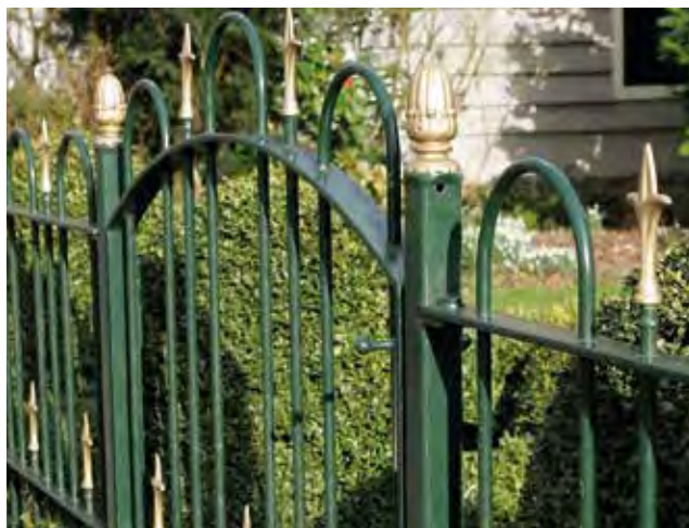
5. Hekwerk in Broek en Waterland
