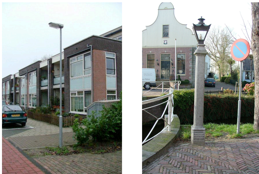
Figuur 2.1 Foto flessenpaal en historische Lichtmasten in Waterland.
