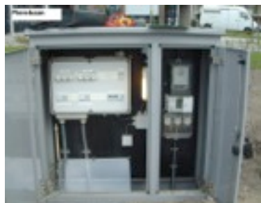
Figuur 2.4 Voorbeeld van een verdeelkast
