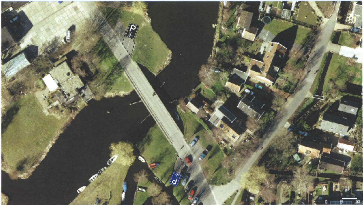
Locatie Broek in Waterland, Wagengouw nabij de brug
