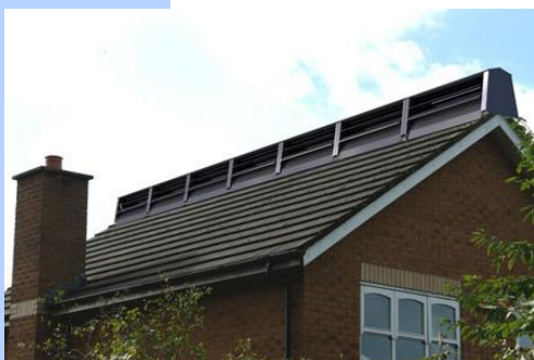
Windenergie op het dak
