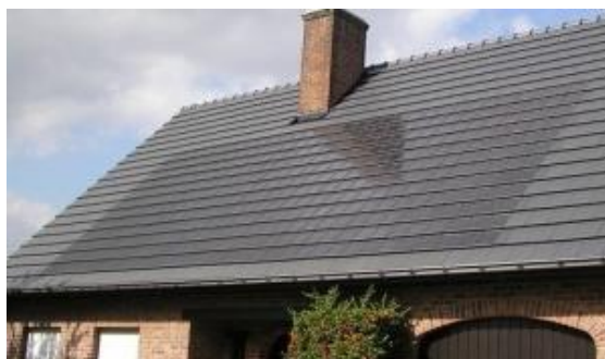
Zonne-energie op het dak
