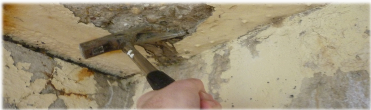
figuur 4.1 Inspectie van de betonnen onderbouw van de Lange brug in Monnickendam
