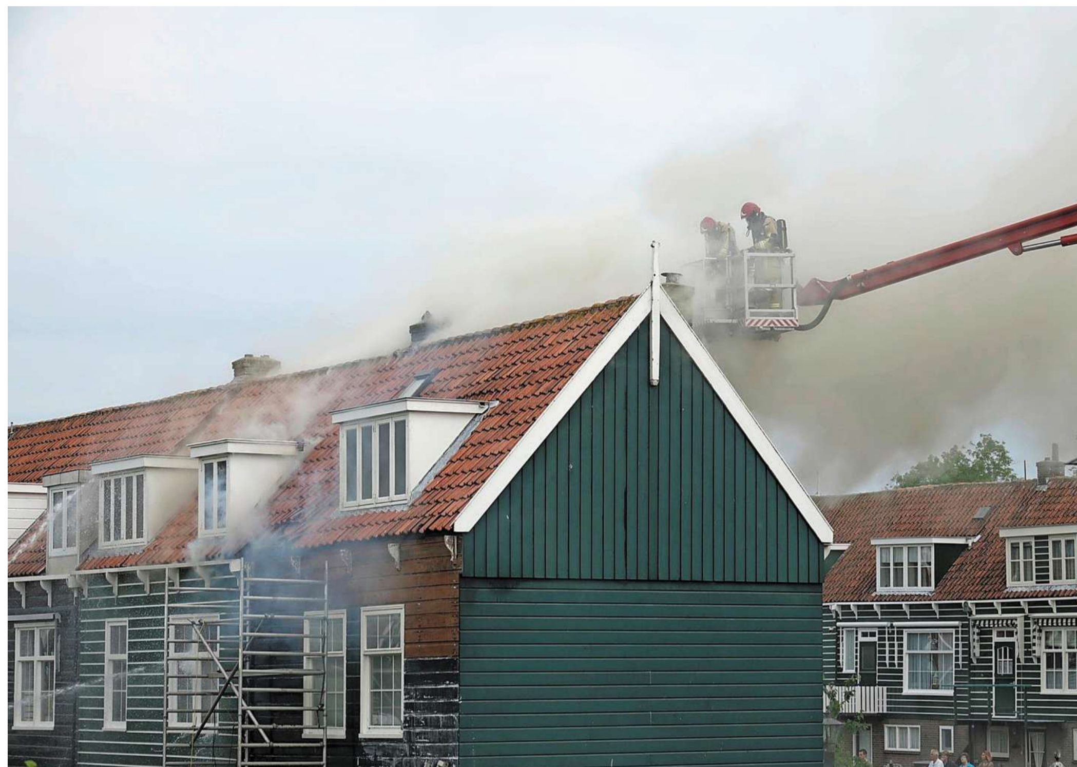
Met behulp van een hoogwerker probeert de brandweer de brand aan de
